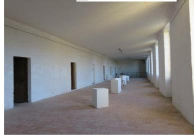
Le sol de la galerie au r+1 est constitué de carrelage de terre cuite posé sur sable. Le plafond de la galerie a fait l'objet d'une rénovation suite aux travaux sur la charpente et la couverture.
