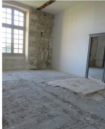
Les sols des cellules à l'étage ont fait l'objet de travaux de rénovation non adéquate : chape de béton coulée directement sur revêtement du sol d'origine.
