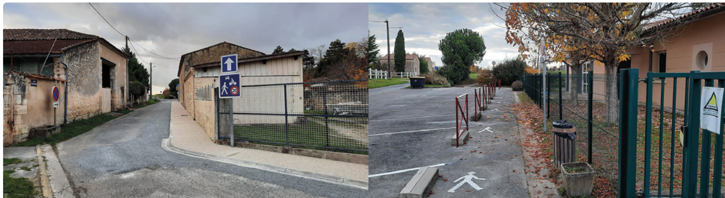
Création cheminement piéton chemin profond ( marquage et trottoir)
