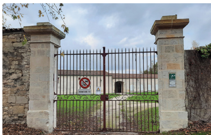
Refection des piliers de l'écomusée
