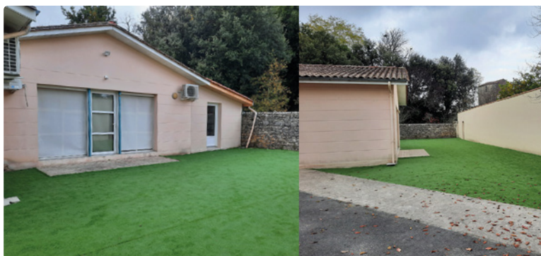
Pose gazon synthétique cour des maternelles Rénovation classe C.P
