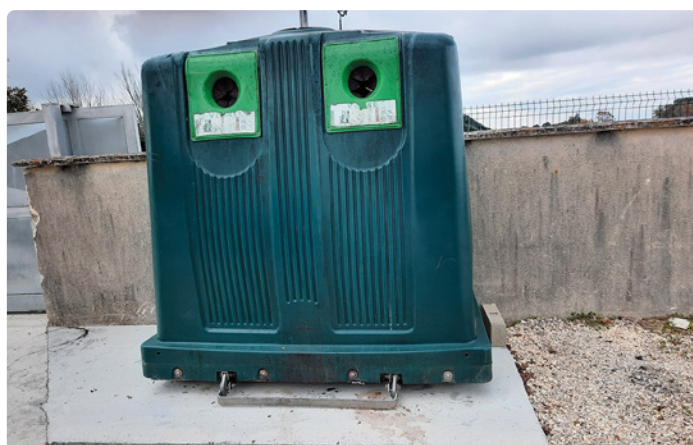
Pose de socles béton sous les colonnes à verre
