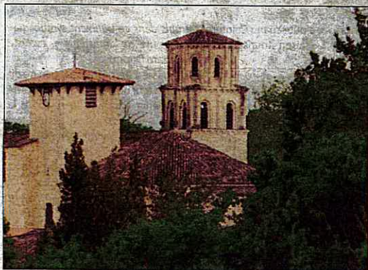
L'abbaye de Vertheuil est l'un des plus vieux vestiges du Médoc. L'édifice ayant été maintes fois attaqué, il n'en reste aujourd'hui qu'une partie.
